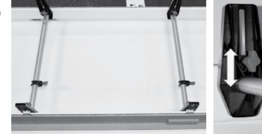
**D** Die Montagespreizer in Höhe des unteren Bandes und im Schließblechbereich einsetzen und festschrauben. Zusätzlich stellen Sie die Montagespreizer auf die entsprechende Wandstärke ein um später die Tür einzuhängen und einzustellen zu können.
