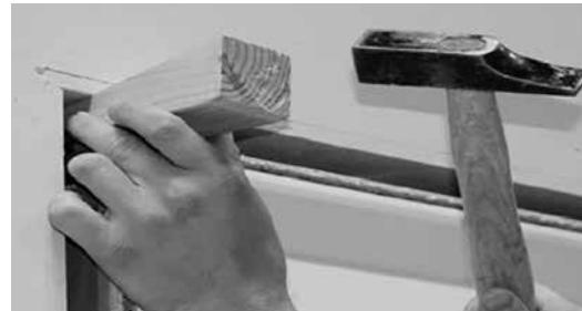
**D** Befestigen Sie an der Gehrung der Bandseite einen Keil um die Zarge von oben zu fixieren. Richten Sie nun die Bandseite lotrecht aus.
