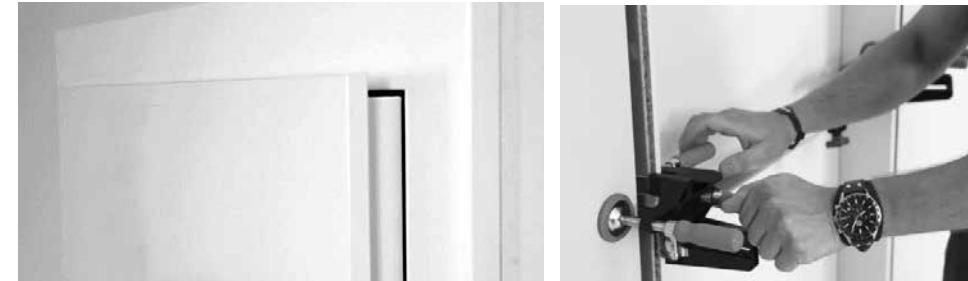
**D** Prüfen Sie nun abschließend die umlaufende gleichmäßige Türluft und kontrollieren Sie nochmals den festen Sitz der Keile, Zargenrichtzwingen, Montagespreizen und der Luftkissen.
