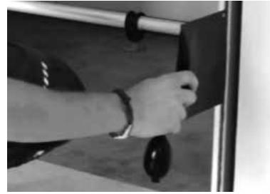
**D** Stecken Sie jeweils Links und Rechts in Höhe der unteren Zargenspreize ein Luftkissen zwischen Zarge und Wand und pumpen Sie diese soweit auf das sie nicht herausfallen.
