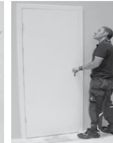
**D** Befestigen Sie an der Gehrung der Schließseite einen Keil und führen eine Funktionskontrolle durch. Prüfen Sie dabei ob die Tür gut schließt und das Türblatt umlaufend auf der Zargendichtung aufliegt.
