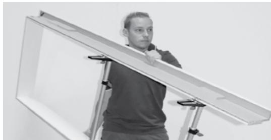
**D** Die Zarge kann nun einfach und ohne verdrehen der Gehrung zum Montageort getragen werden. Die Montagespreizer halten während des Transports die Zargenbreite immer auf dem eingestellten Maß.
