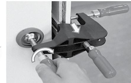
**D** Sie können die Bandseite durch Verstellen der Zargenrichtzwingen und Aufpumpen oder Ablassen der Luftkissen justieren. Nach dem Ausrichten muss die Zarge im Mauerloch fest fixiert sein.
